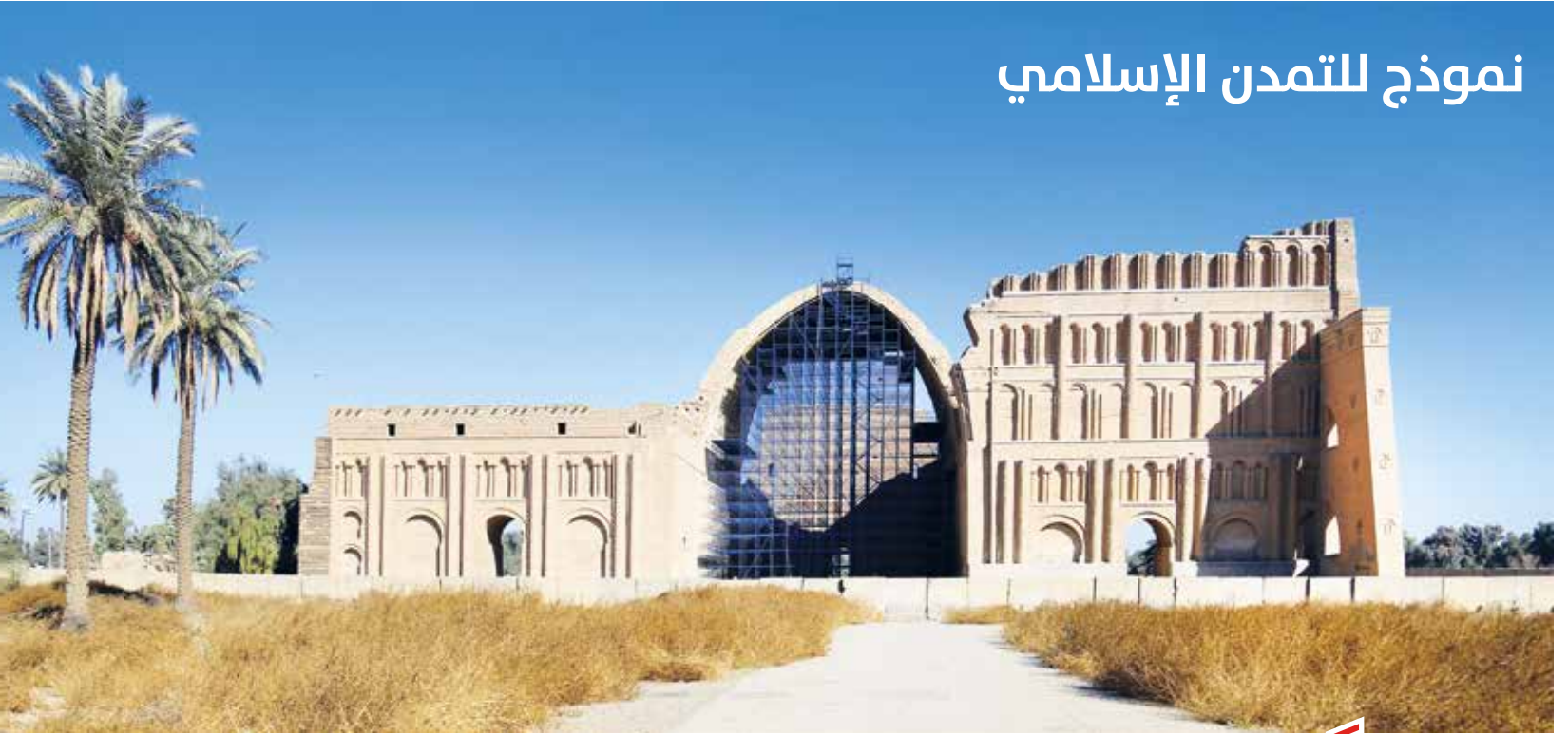
طاق كسرى، الواجهة الشرقية.
